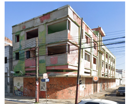
► Figura 11: Edifício na Rua Solon Pinheiro, 261.
