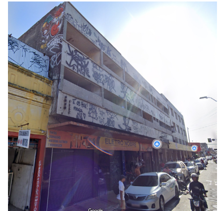
► Figura 10: Edifício na .
