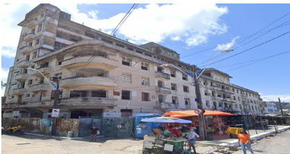
Figura 2: Edifício na Rua 24 de Maio, 571.
