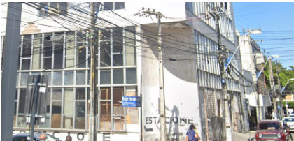
Figura 3: Edifício na Rua Senador Alencar, 80.
