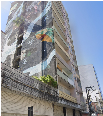
► Figura 4: Edifício na Rua do Rosário, 263.
