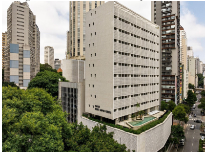
► Figura 4: Edifício Renata Sampaio Ferreira.
