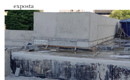
► Figura 1: Impermeabilização da piscina
