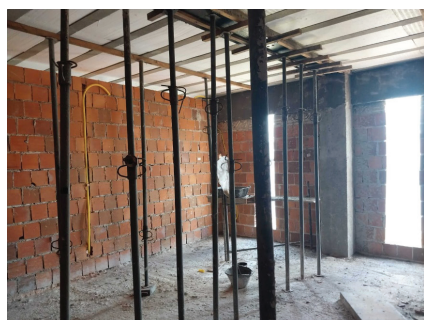
► Figura 1: Escoramento na obra da câmara municipal
