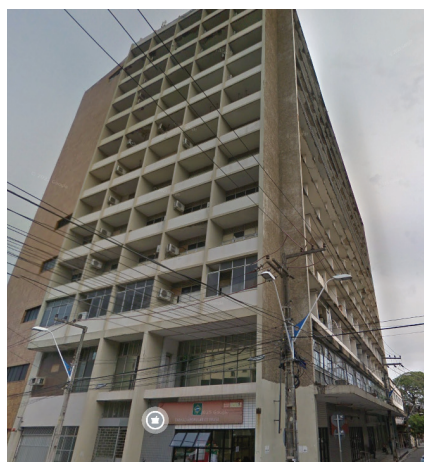
► Figura 5: Edifício na Rua Castro e Silva, 120.
