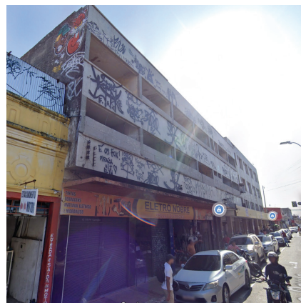
► Figura 10: Edifício na .
