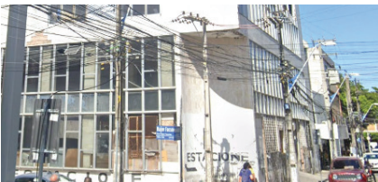
Figura 3: Edifício na Rua Senador Alencar, 80.
