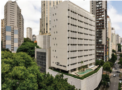
► Figura 4: Edifício Renata Sampaio Ferreira.
