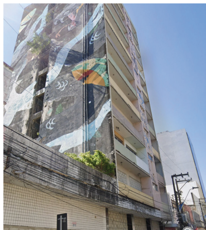
► Figura 4: Edifício na Rua do Rosário, 263.
