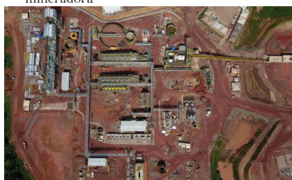
► Figura 1: Vista superior da obra da usina mineradora
