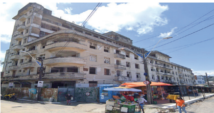
Figura 2: Edifício na Rua 24 de Maio, 571.
